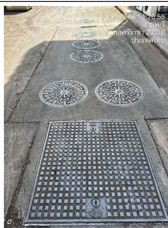
ภาพที่ 11 ระบบบำบัดน้ำเสียสำเร็จรูป ชนิดเกรอะ-กรองไร้อากาศ
