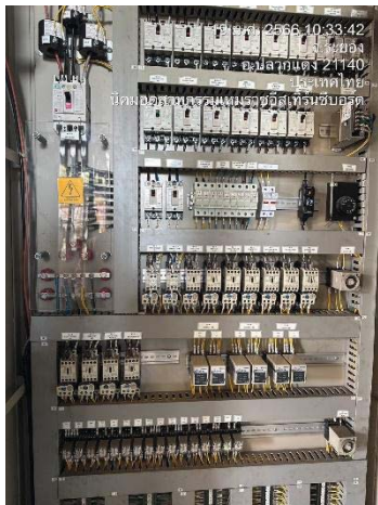
ภาพที่ 38 อุปกรณ์ไฟฟ้าที่มีสายดินทุกระบบ
