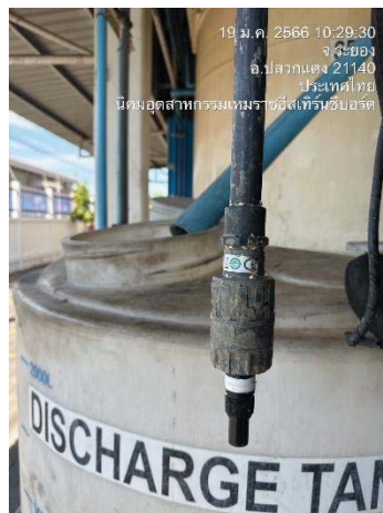
ภาพที่ 15 เครื่องตรวจวัด pH แบบอัตโนมัติ
