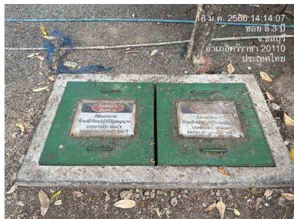
ภาพที่ 7 บ่อตรวจวัดคุณภาพน้ำ (inspection manhole)
