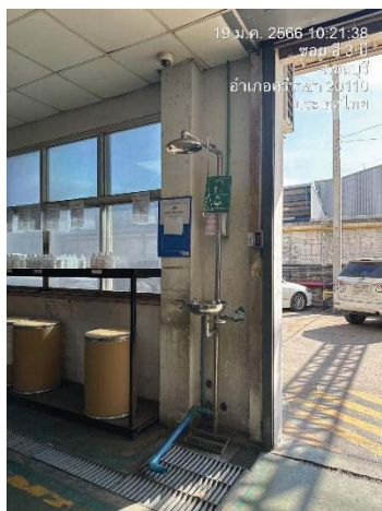
ภาพที่ 30 ฝักบัวและที่ล้างตาฉุกเฉิน
