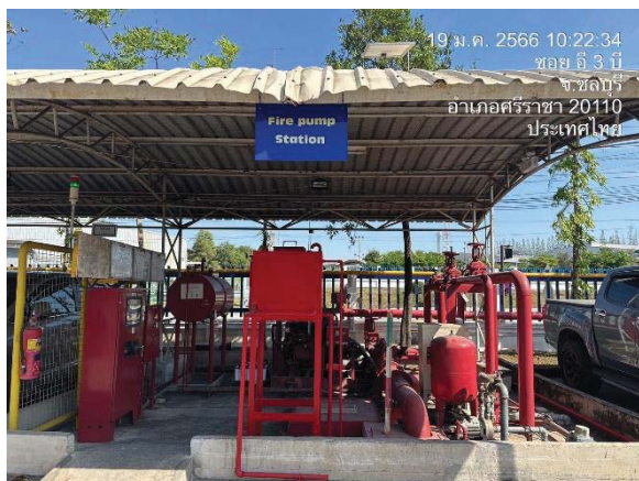
ภาพที่ 42 เครื่องสูบน้ำดับเพลิง และหัวรับน้ำดับเพลิง
